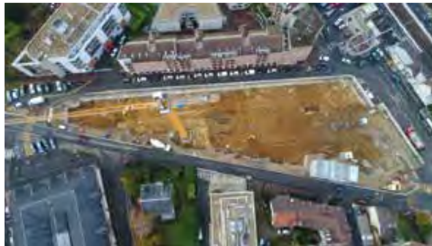
▲ Cœur Citadin : terrassement terminé, réalisation en cours des fondations.
