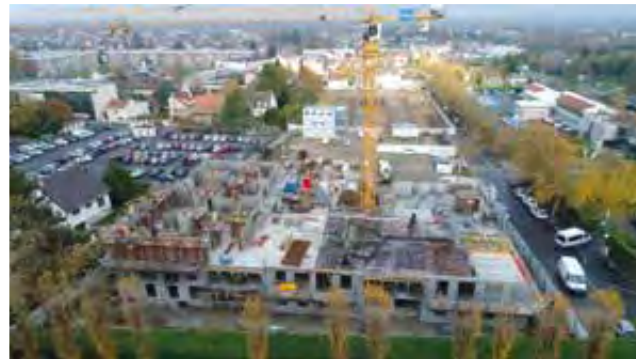
▲ Cœur Éclat : les bâtiments sont sortis de terre. À l'arrière-plan, préparation des sols de l'îlot « Cœur Jardin ».
