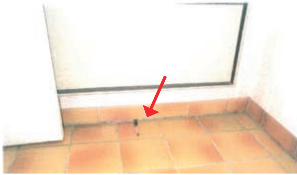
Affaissement du plancher mis en évidence par le décalage entre plinthes et dallage - Maison Jourdan.
