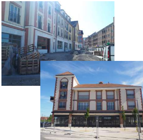
Logements en cours de réalisation – Cœur de Ville (source : atopia)
